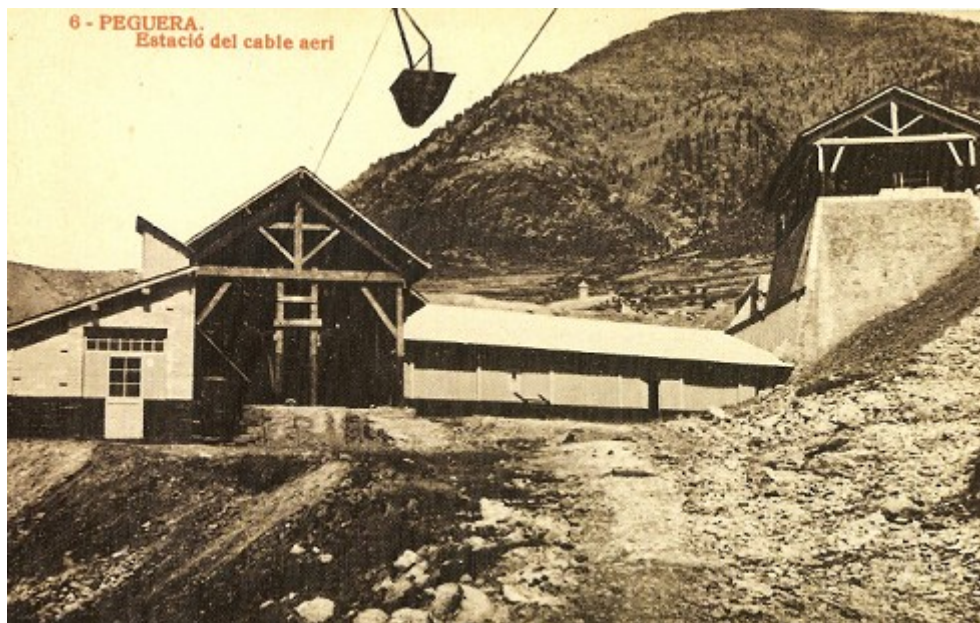
Figura 4: Estació de càrrega del segon telefèric de Peguera. Segona dècada del S.XX. Font: Serra, 2003.
